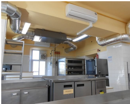
Remont sali nr 18
